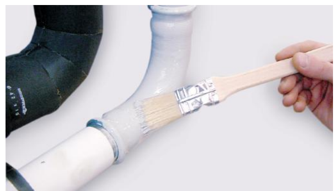
Ilustracja 37 - Malowanie podkładem rur i kształtek.
