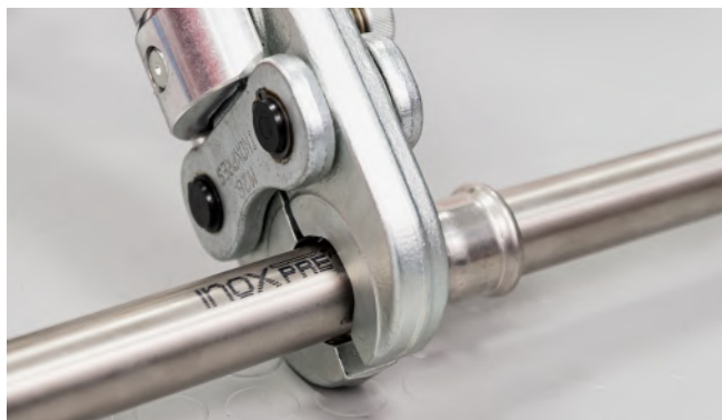
Ilustracja 32 – Wykonywanie złącza
