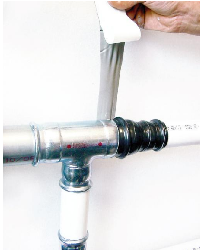
Ilustracja 38 - Ochrona połączeń taśmą izolacyjną
